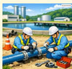
浄・給水場の敷地内での工事
