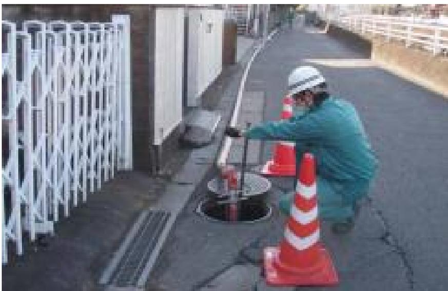
配水管に設置されている消火栓から勢いよく水を吐出させ、管の内部をきれいな状態に保ちます。
