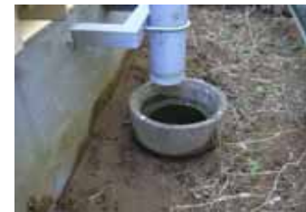
オーバーフロー管の状況
