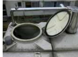
マンホールの状況
