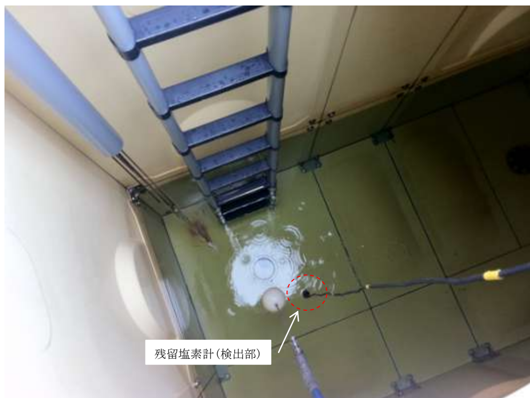
写真 3. 2. 2 B 調査の実施状況 (NO. 2: 受水槽内部)
