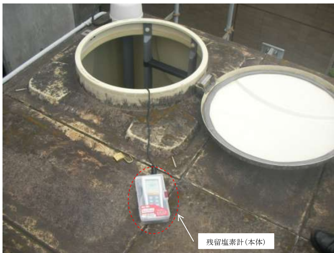
写真 3. 2. 1 B 調査の実施状況 (NO. 2: 受水槽上部)
