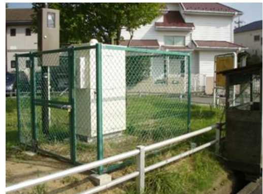
図V—6 水質自動監視装置
