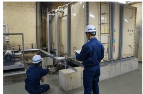
図V—8 貯水槽の点検の様子
