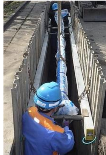
図V—7 配水管の布設替えの様子
