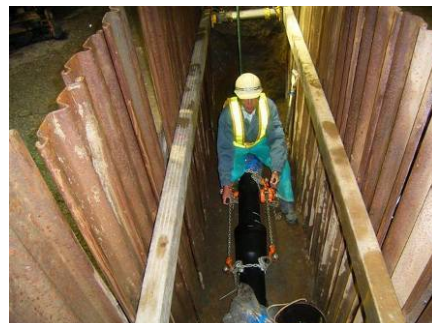
<配水管の布設替え工事>
