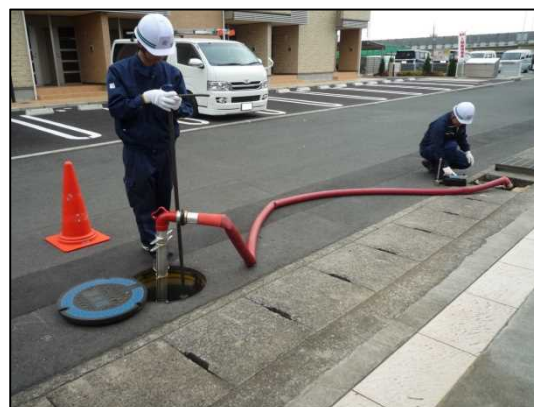
図 1 7 管内洗浄の様子
