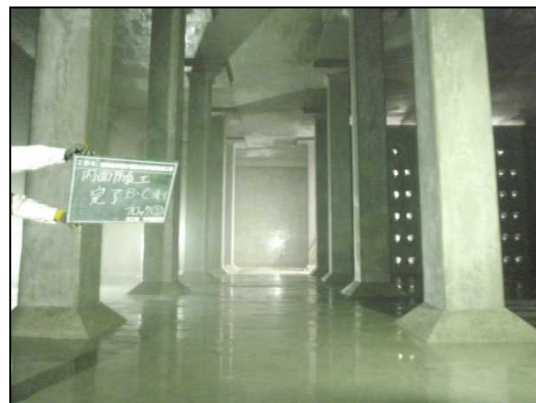
図11 配水池の防水塗装
