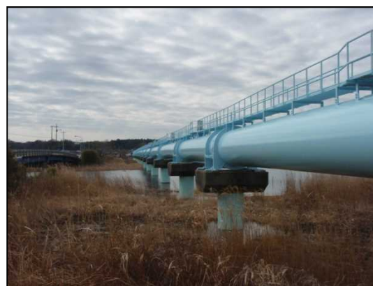
図 1 5 水管橋塗装（船戸）
