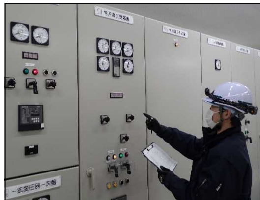
図9 職員による設備点検
