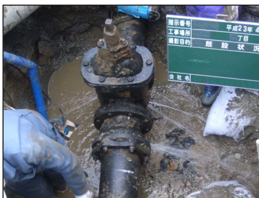
図7 東日本大震災の液状化で漏水した管路
