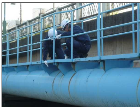
図 1 4 管路パトロールの様子
