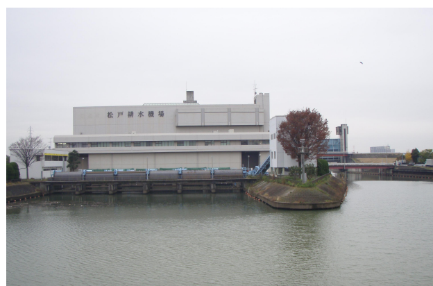
松戸排水機場 (坂川)
