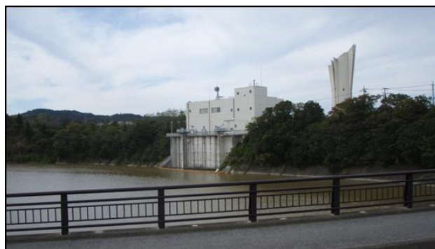
高滝取水場 (高滝ダム)
