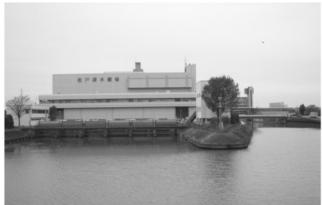
松戸排水機場 (坂川)
