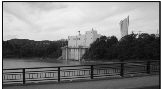
高滝取水場 (高滝ダム)
