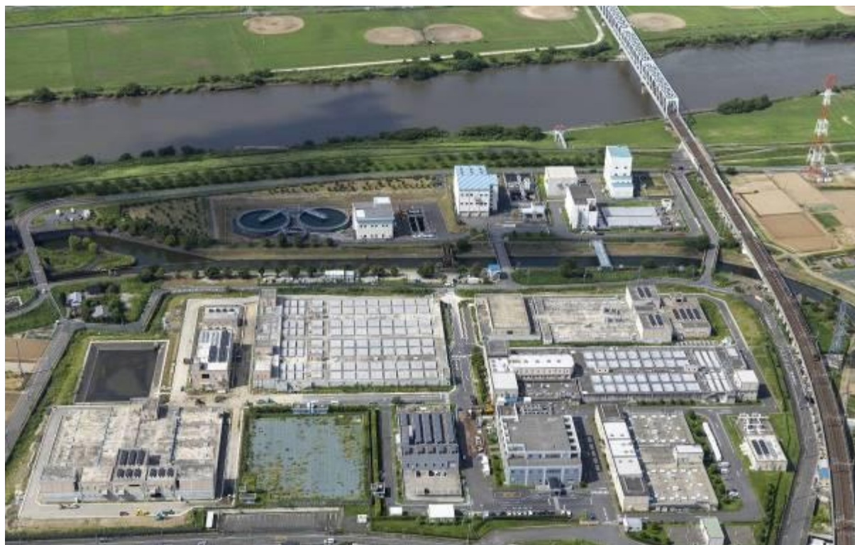
ちば野菊の里浄水場航空写真（令和6年3月から2期施設稼働）
