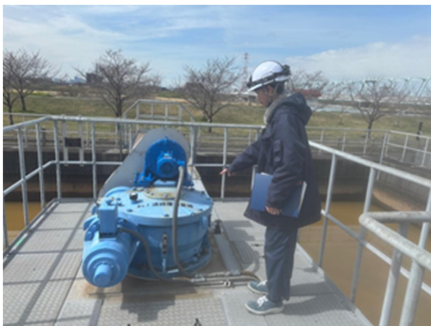
写真 4 濃縮槽掻寄機確認（設備稼働状況確認）
