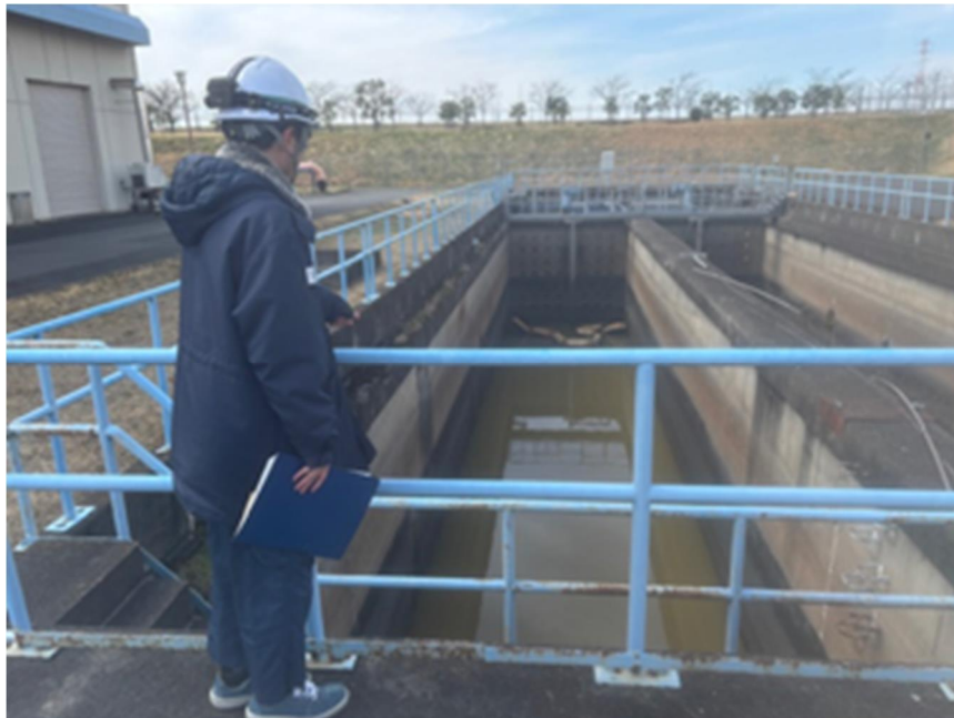
写真 7 上澄水槽確認（上澄水施設及び水質確認）
