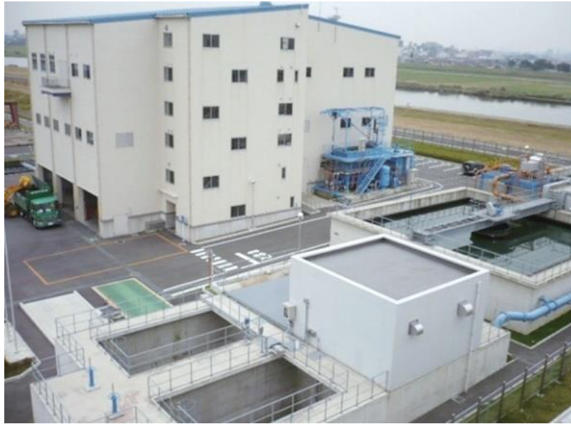
写真 1 本事業により整備した脱水機棟及び濃縮槽
