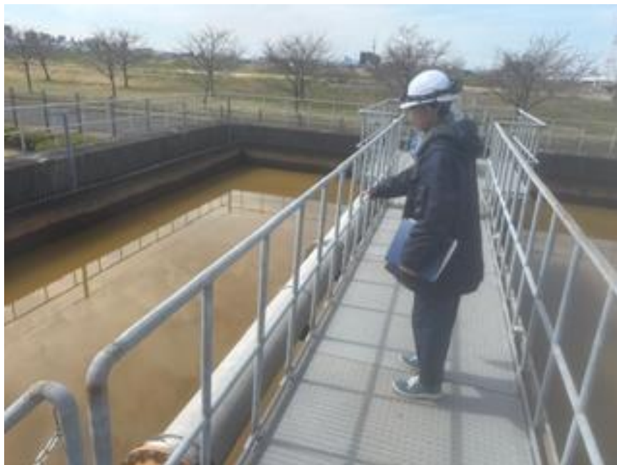
写真 3 濃縮槽確認（汚泥沈降状況確認）
