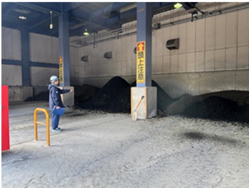
写真 10 ケーキヤード状況確認 (発生土状況及びヤード整理状況確認)
