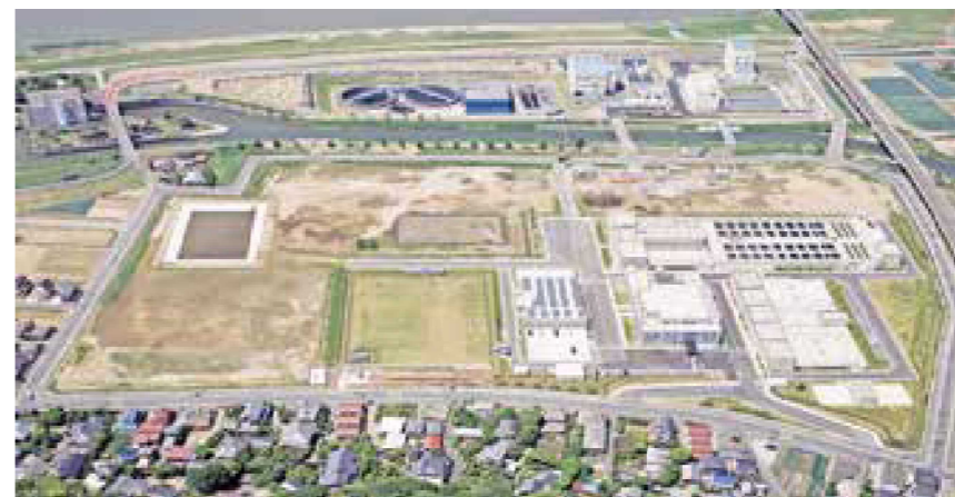
ちは野菊の里浄水場(松戸市)
