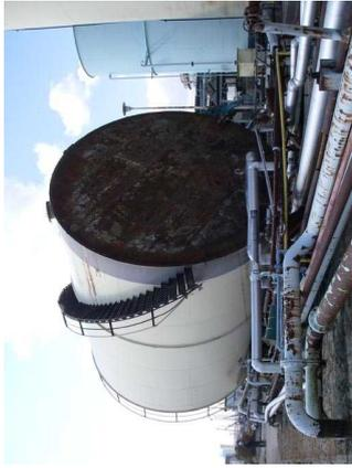
写真8 転倒した劇物のタンク（地震時は空）
