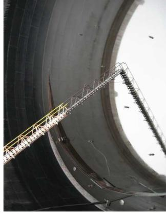
写真40 浮き屋根の沈没
