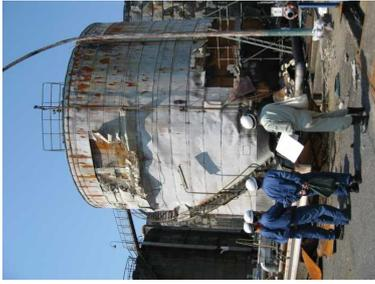
写真 29 隣接区画のアスファルトタンクの側板が損傷
