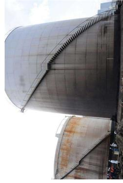
写真5 重油が漏洩したタンク(側板には漏洩した際に飛散した油が付着している)
