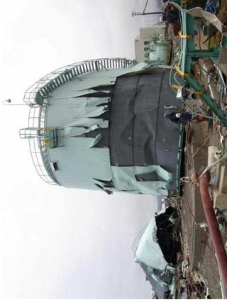
写真53 保温材が剥離、消失し、側板が座屈したタンク
