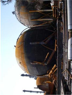
写真 26 ガスタンクの支柱が屈曲し配管が損傷
