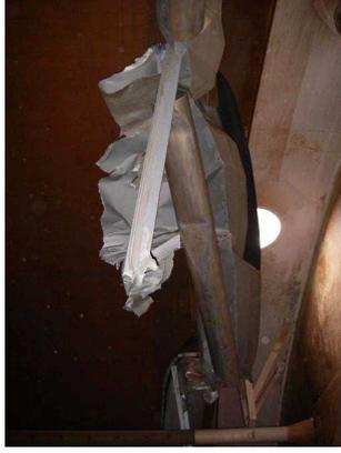
写真49 破断したクランプビーム
