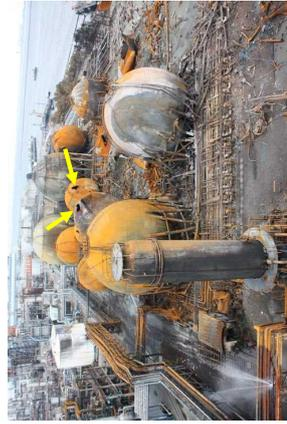
写真 30 噴破したガスタンク (矢印の箇所が開いた部)
