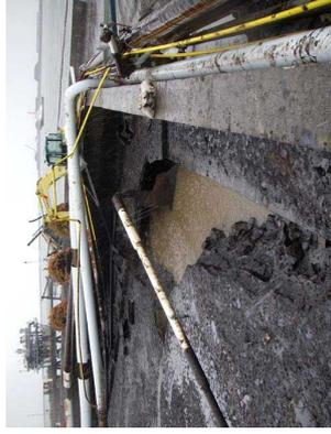
写真2 防油堤直下の基礎の洗掘
