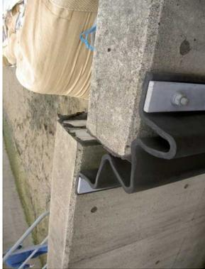
写真36 防油堤の破断状況（ゴムシートは破断していない。）
