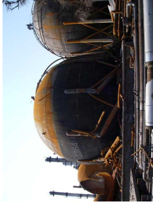
写真 26 ガスタンクの支柱が座屈し配管が損傷
