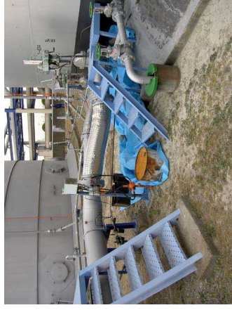
写真 32 タンク付近が液状化、タンクが沈下
