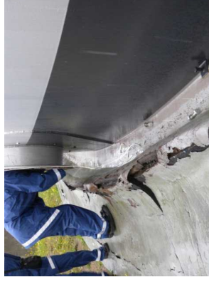
写真 33 タンク沈下、基礎の変形
