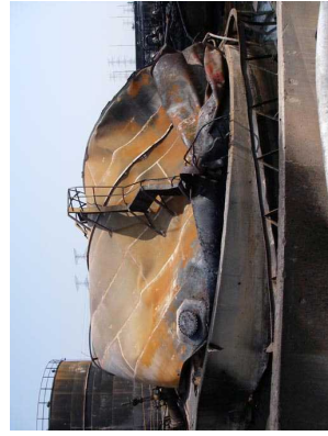
写真 17 焼損したガソリントタンク
