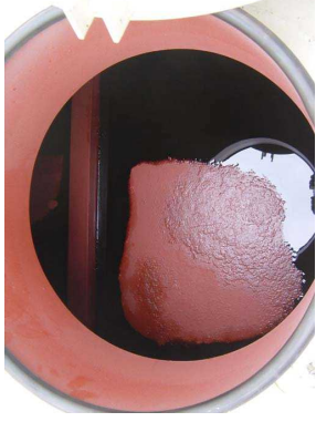
写真 39 ポンツーン内への原油の滯油
