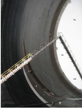
写真 40 浮き屋根の沈没
