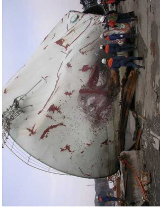
写真10 津波により移動、倒壊したタンク
