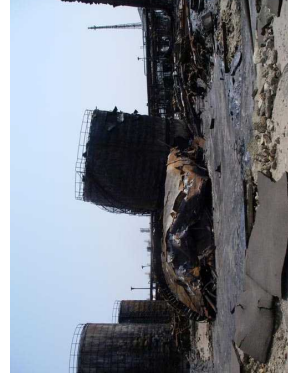
写真 20 倒壊したアスファルトタンク
