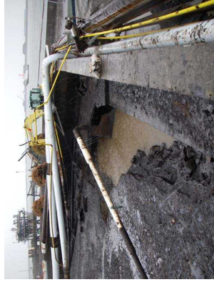
写真2 防油堤直下の基礎の洗掘
