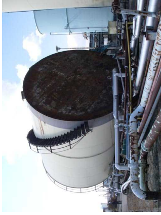
写真8 転倒した劇物のタンク（地震時は空）
