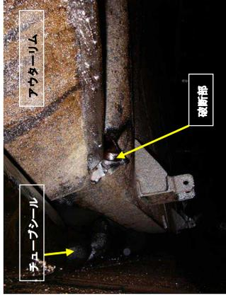
写真41 浮き屋根下部の破断状況
