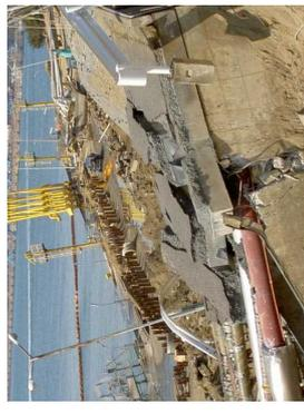
写真14 護岸の被害
