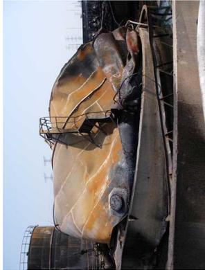
写真 17 焼損したガソリントタンク
