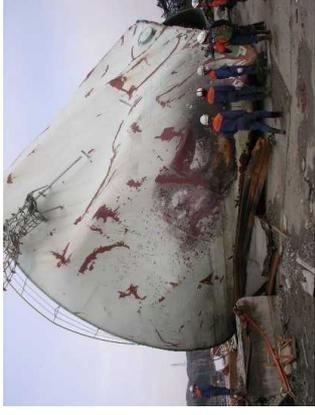
写真10 津波により移動、倒壊したタンク
