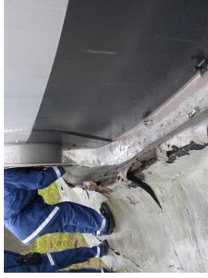
写真 33 タンク沈下、基礎の変形
