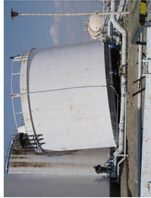
写真7 津波により浮上・移動したタンク (容量2千kL、地震時は空)
