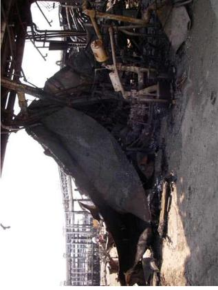
写真 21 柱に衝突したアスファルトタンクの屋根
