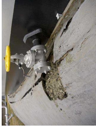
写真 31 タンク沈下でバルブの下部が基礎に接触
