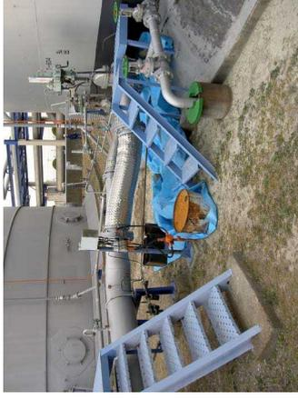
写真 32 タンク付近が液状化、タンクが沈下
