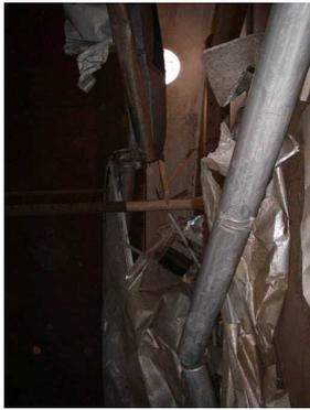
写真45 大破したアルミ製の内部浮き蓋
