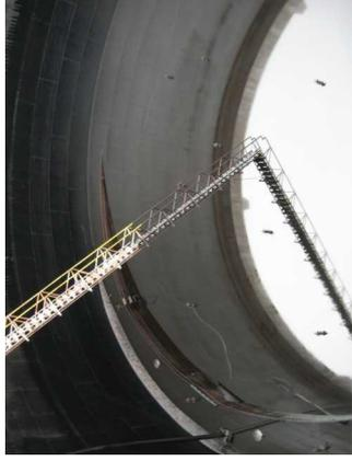
写真40 浮き屋根の沈没
