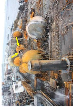
写真 30 噴破したガスタンク (矢印の箇所が開裂部)
