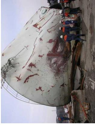
写真10 津波により移動、倒壊したタンク
