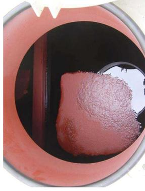
写真39 ポンツーン内への原油の滯油
