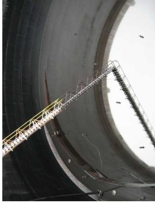
写真40 浮き屋根の沈没
