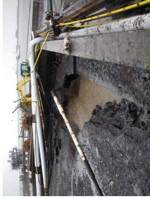
写真2 防油堤直下の基礎の洗掘
