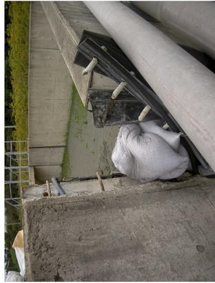
写真37 防油堤の破断状況（ゴムシートが破断し、大きく開口。）
