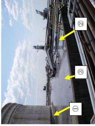
写真1 危険物が防油堤内に漏洩した状況
