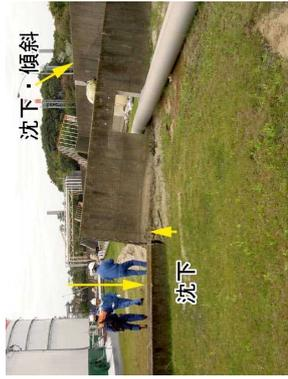
写真35 液状化により沈下・傾斜した防油堤
