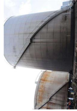
写真5 重油が漏洩したタンク(側板には漏洩した際に飛散した油が付着している)
