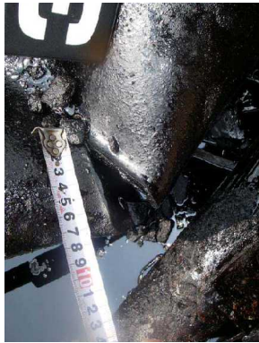
写真3 重油配管の開口部
