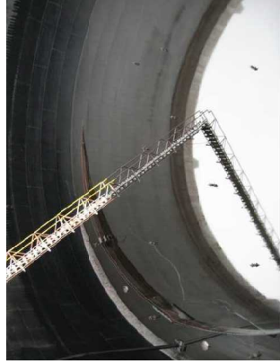
写真 40 浮き屋根の沈没
