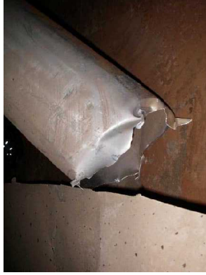
写真48 破断したフロートチューブ2
