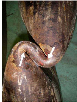
写真4 ガソリン配管(直径14インチ)の屈曲部と割れ(矢印部2箇所)
