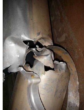
写真47 破断したフロートチューブ(直径25.4cm、長さ6.7056m)
