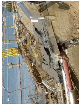
写真14 護岸の被害
