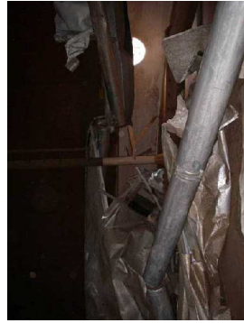
写真45 大破したアルミ製の内部浮き蓋
