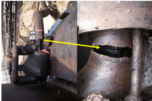
写真6 破断した重油タンクの配管
