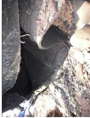
写真 19 ガソリタンク破断部
