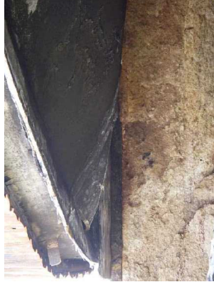
写真 24 硫黄タンクの底板の破断部
