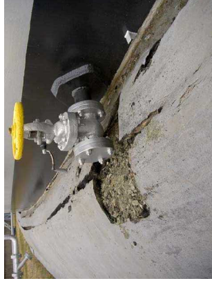
写真 31 タンク沈下でバルブの下部が基礎に接触
