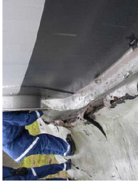
写真 33 タンク沈下、基礎の変形
