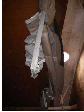
写真49 破断したクランプビーム
