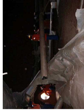
写真46 破断したデッキスキム、フロートチューブ
