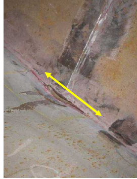
写真 44 ポンツーンとデッキとの溶接線の割れ（長さ約 20cm）亀裂はデッキ板を貫通している
