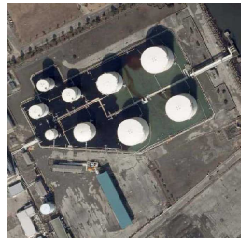
写真9 防油堤内に滞留した重油とガソリン (国土地理院提供)
