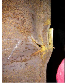
写真 43 ポンツーンの破断部（アウトワーリムとローアアークデッキの溶接線近傍）
