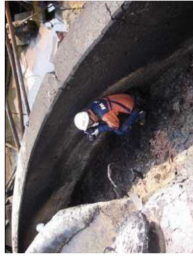
写真 18 タンク基礎は人が隠れるほど流出
