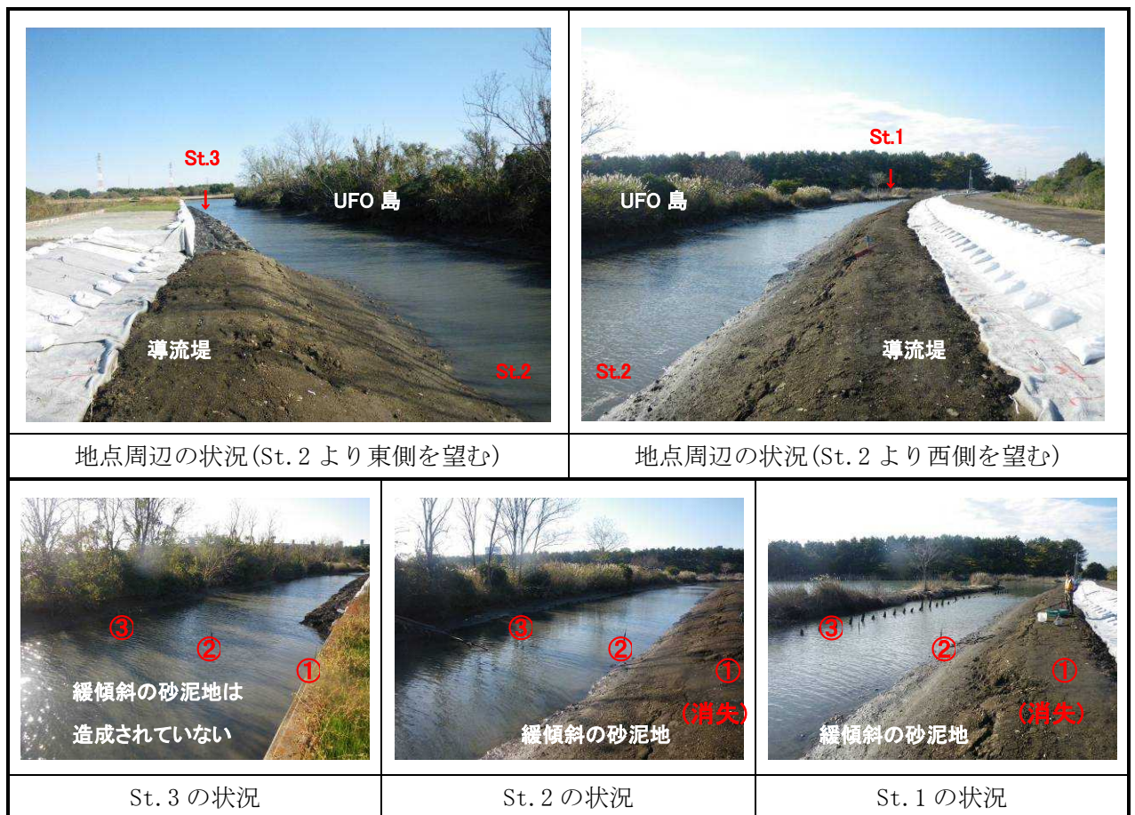
写真 4-4 覆土施工後(2011年11月22日) 底質調査地点の状況
