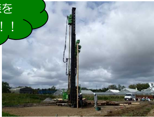
秋田県大湯村でのLP-SoC工法の施工
