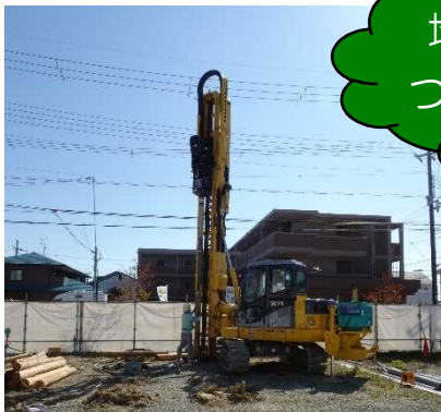
兵庫県明石市でのLP-SoC工法の施工
