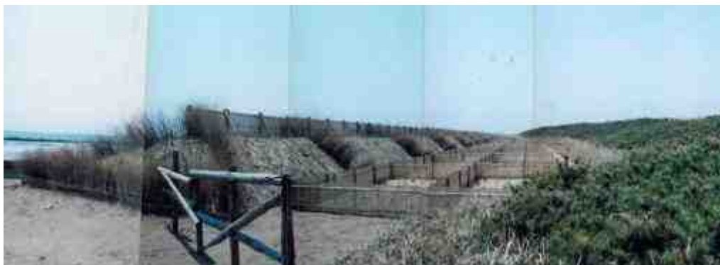
砂丘工～木製防風工～植栽（旭市三川）
