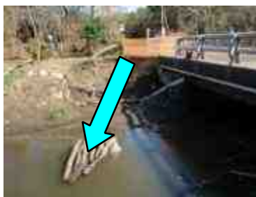
護岸工の損傷（山武市）
