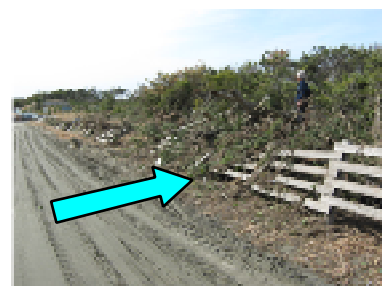
防風柵の倒壊（旭市）
