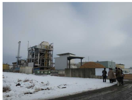
地域熱供給プラント
