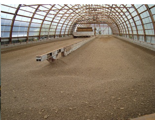
機械攪拌式（回行式）堆肥製造施設
