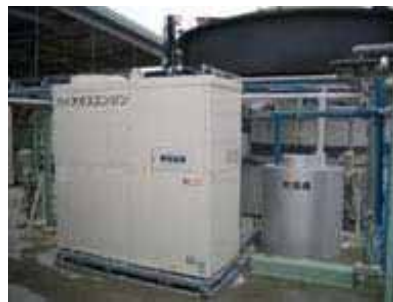
コージェネレーション設備
