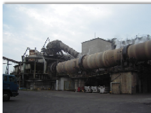
太平洋セメント(株)埼玉工場のセメントキルン
