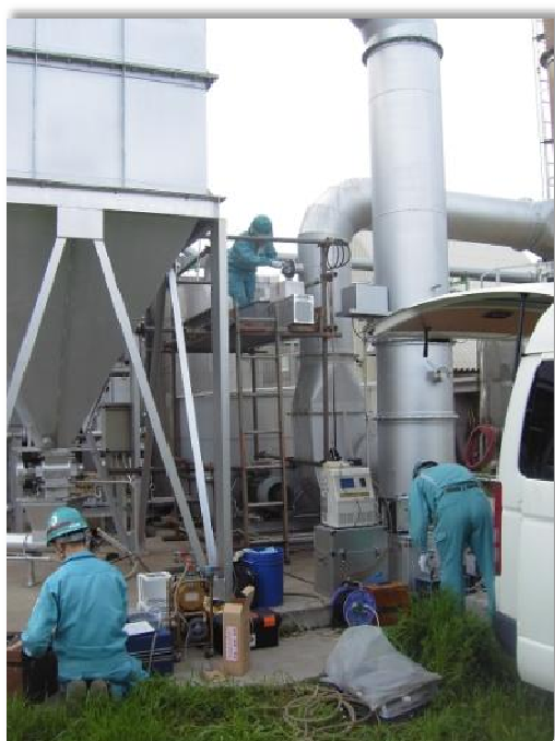
バイオマスボイラーでの堆肥燃料混焼試験 (排ガスの測定)
