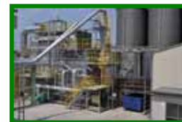
バイオマスボイラー
