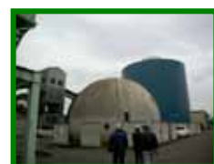
メタンガスのタンク
