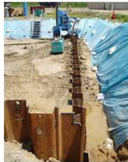
写真3-1 遮水壁(鋼矢板)の打設状況
