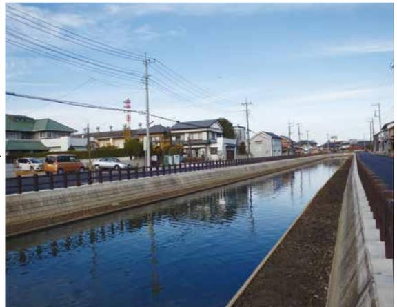
東日本大震災で被災した護岸の復旧の様子(香取市・小野川)
