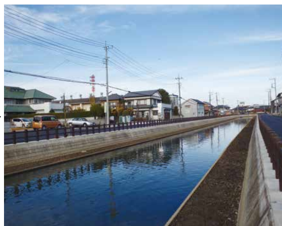
東日本大震災で被災した護岸の復旧の様子（香取市・小野川）
