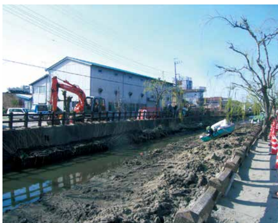
東日本大震災で被災した護岸の復旧の様子（香取市・小野川）
