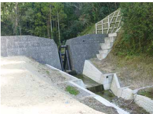
土砂災害を防止する施設
