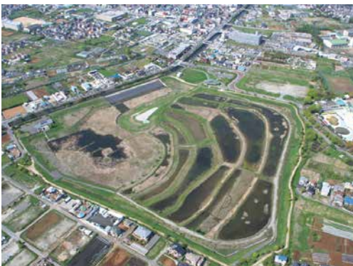
洪水を一時的に貯留する施設(大柏川第1調節池)
