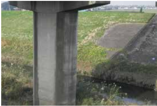
橋りょうの耐震補強(橋脚補強前)
