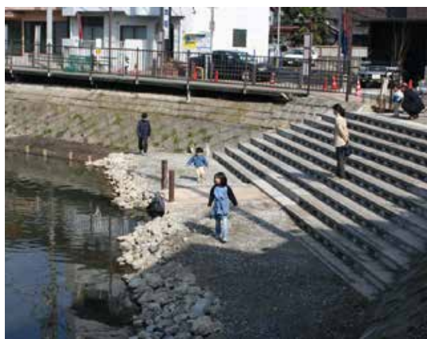
親水護岸の整備(坂川)
