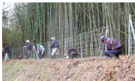
イノシシ被害防止のための防護柵を設置
