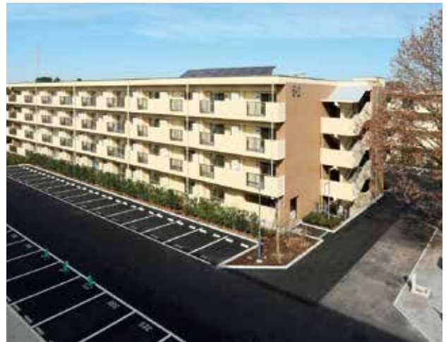
千城台西県営住宅建替工事第4期2工区 (2016年度竣工)
