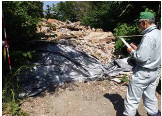
建築廃材の不適正保管に係る測量の様子
