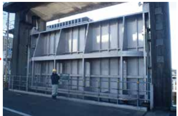
河川施設の長寿命化（施工後）
