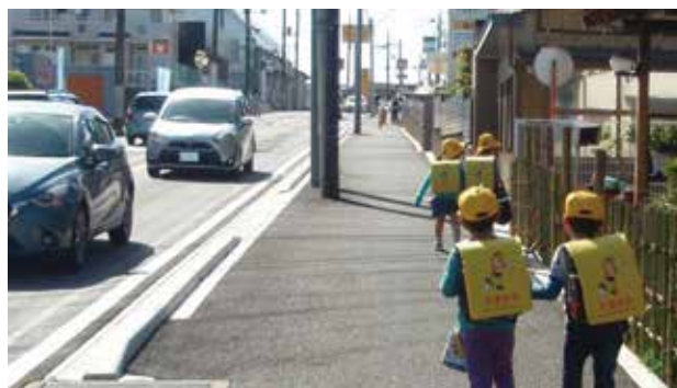
通学路の歩道整備
