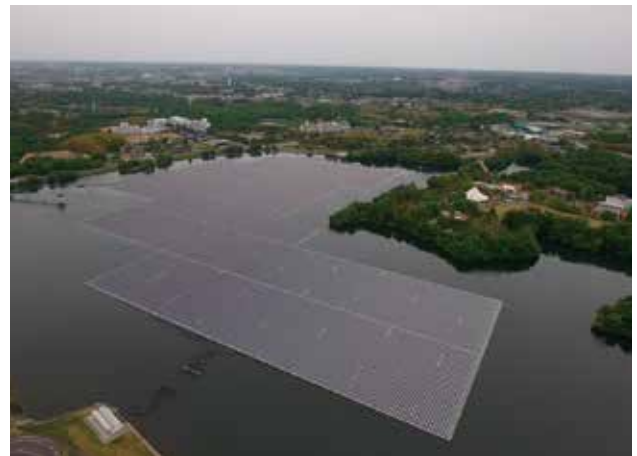
山倉ダムの水上に設置された 千葉・山倉水上メガソーラー発電所
