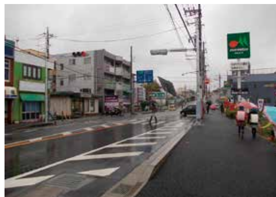
信号機の設置後
