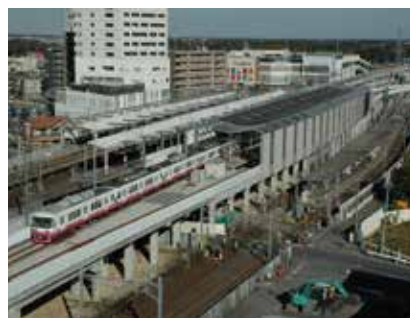
新京成線連続立体交差事業
