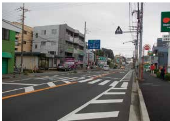
信号機の設置前
