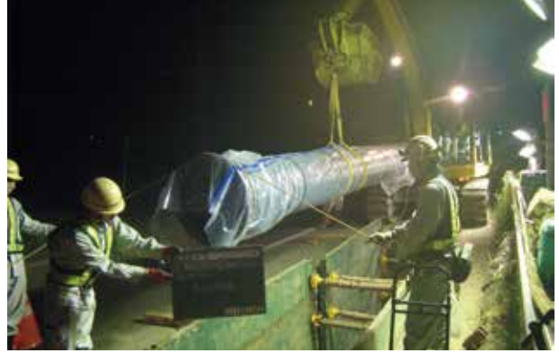
管路の整備工事(耐震管の布設)
