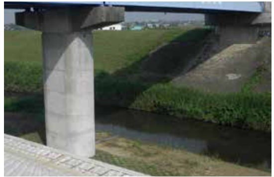
橋りょうの耐震補強(橋脚補強後)
