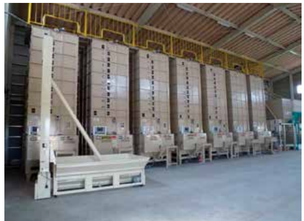
大規模な稲作経営に対応した穀物乾燥調製施設の整備
