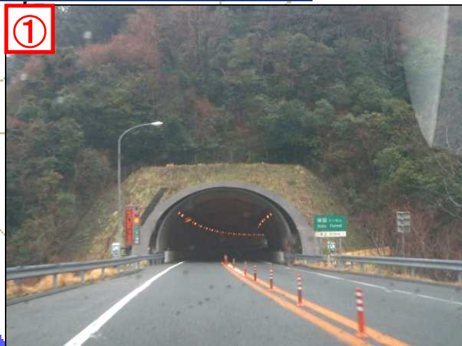
保田トンネル入口
