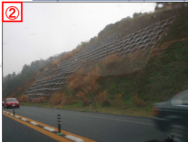
南房総市富浦町深名地先の法面
