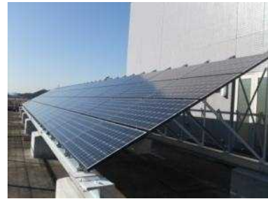
太陽光発電設備（長生合同庁舎）
