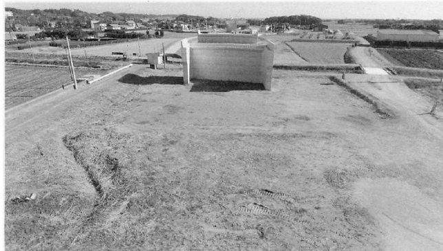
着手前 (起点側から望む)
