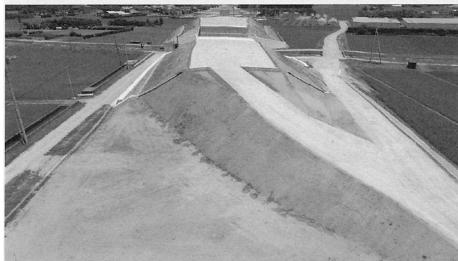
完成 (起点側から望む)
