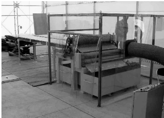
写真1 破碎分離装置
