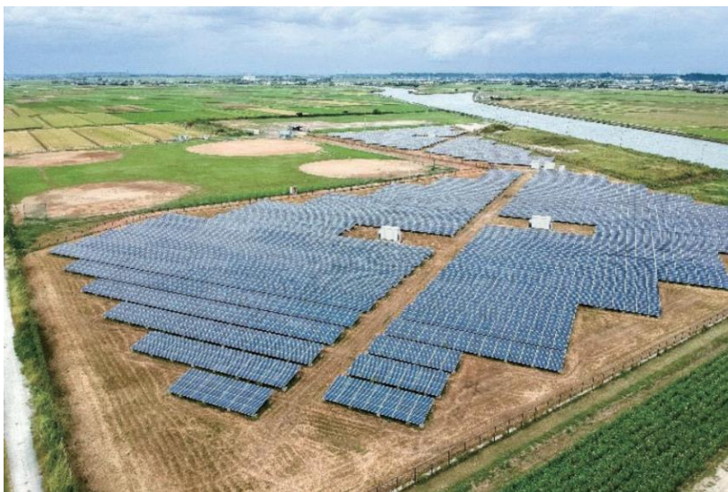
写真 4-6-1 与田浦太陽光発電所 出典 (株)成田香取エネルギー
