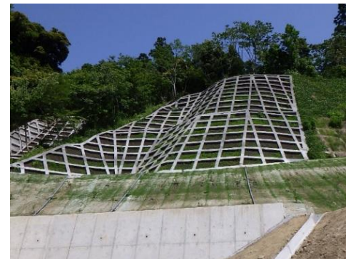
治山施設の設置
