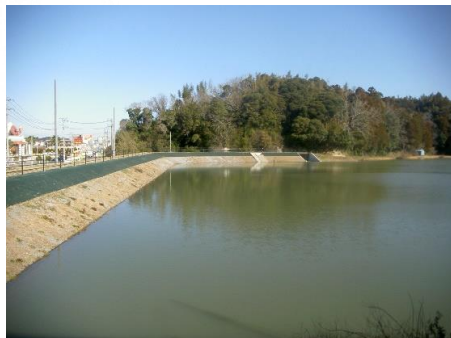
改修工事後の防災重点農業用ため池
