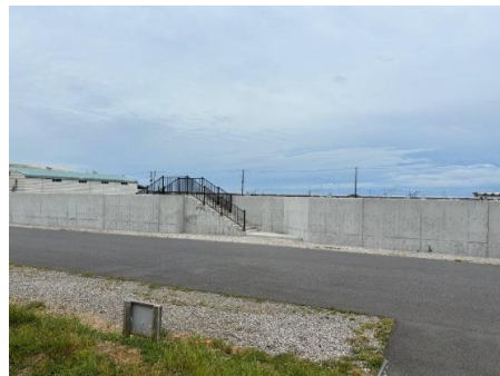
新設した海岸防潮堤
