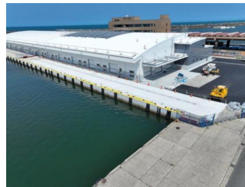
銚子漁港第3卸売市場荷さばき施設
