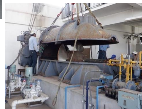
長寿命化対策を実施した農業水利施設
