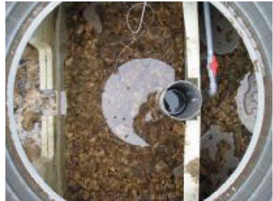
図2 SC材を用いた浄化槽内部の状況
