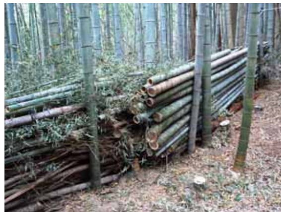
写真2 竹防護柵の設置状況
