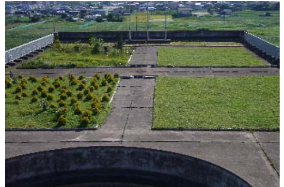
写真1 緑化用保水基盤材とマット植物の組み合わせによる屋上緑化 (右手前、市原八幡高等学校)
