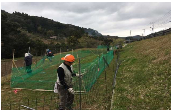
防護柵の設置作業
