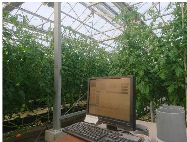
環境モニタリング装置で管理された施設
