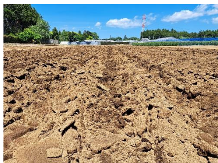
カットブレーカーによる硬盤破碎
