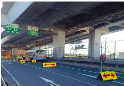
NEXCO 東日本管内 川崎浮島入口交通規制
