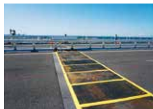
養生後 (ゴムマット設置)
