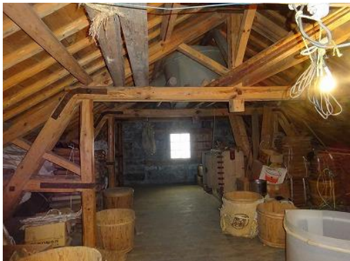
仕込蔵（醪蔵）小屋組
