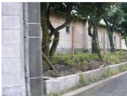
学校敷地の西側、北側にある古くなったブロック塀の至る所に亀裂や歪みが生じ、崩れそうな状態となった。特に、西側20mほどあるブロック塀は、今にも崩れそうで危険な状態であったため、ブロックを取り外し、現在は杭を打ってロープを張った状態となっている。
