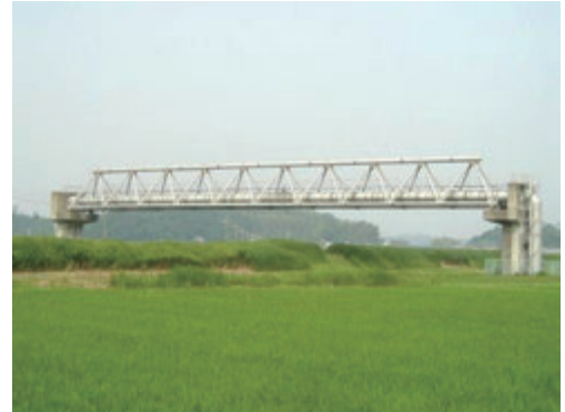
成田用水（水管橋）
